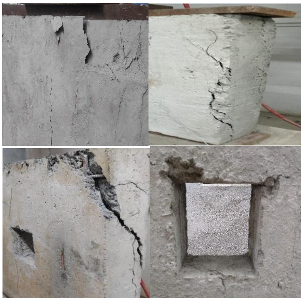
Fig. 12 (a) Surface crack (b) Edge crack (c) Corner crack (d) Opening crack (Close-up View)
